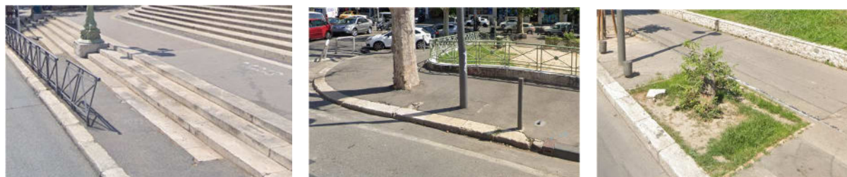
Revêtements de la Place des Marseillaises : entre enrobé classique et bordure en pierres calcaire de Cassis
